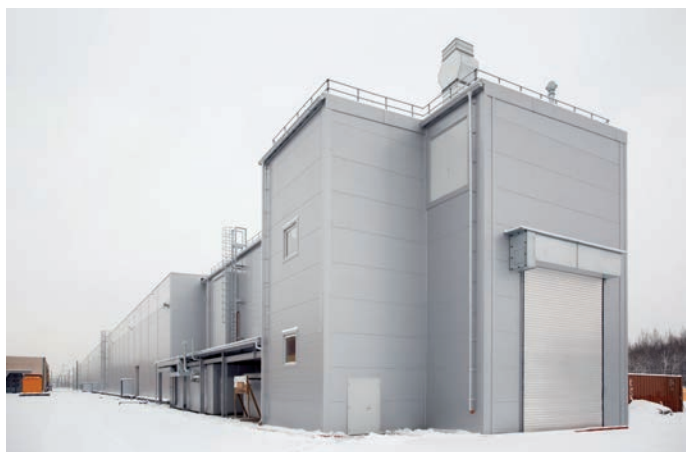
Cabina de gran capacidad de Dürr instalada en las inmediaciones de San Petersburgo.
