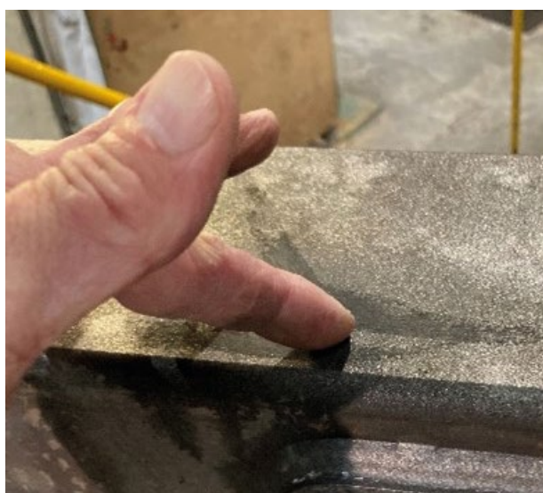
Fig. 5 Filtro obstruido prematuramente Fig. 6 Medios de chorreado con demasiado polvo Fig. 7 Chorreado pero no limpio.
