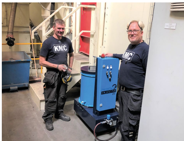
Fig. 2 El sistema de dosificación completamente instalado en un gran sistema de granallado con 12 ruedas de granallado.
