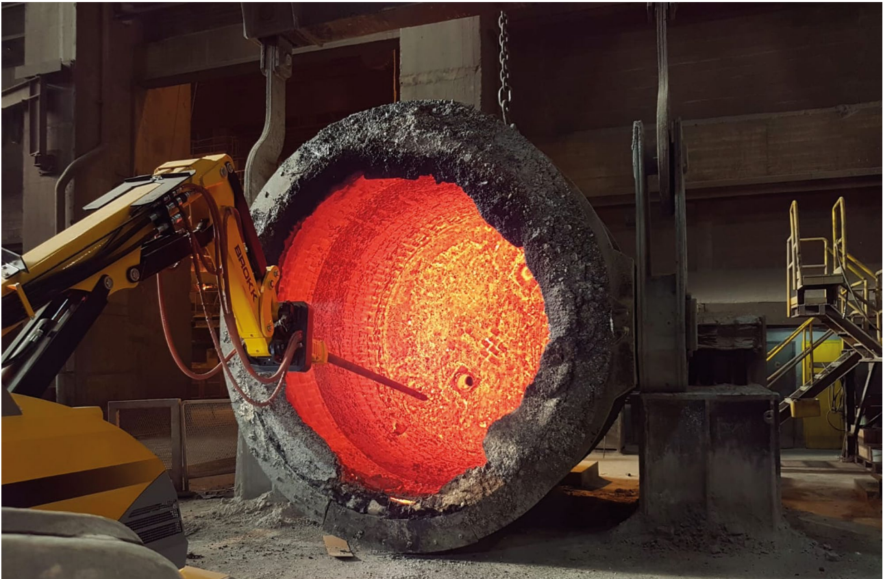
Robot de demolición quitando buzas.
