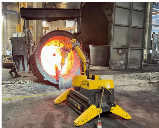
Robot Brokk 70 demoliendo refractario a alta temperatura.
