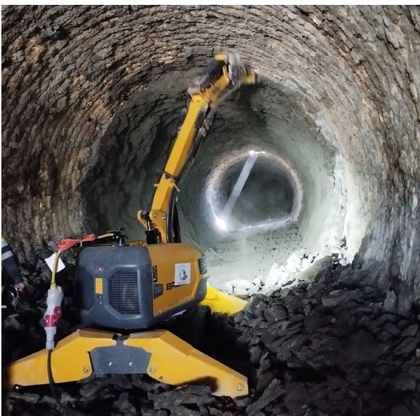
Robot Brokk trabajando para la empresa Benvac Global Services S.L.
